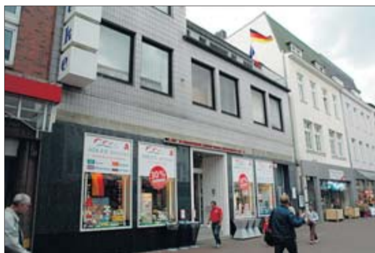
Solche Fassaden wirken nicht einladend, sie prägen aber das Bild der Fußgängerzone Lüneburger Straße.
